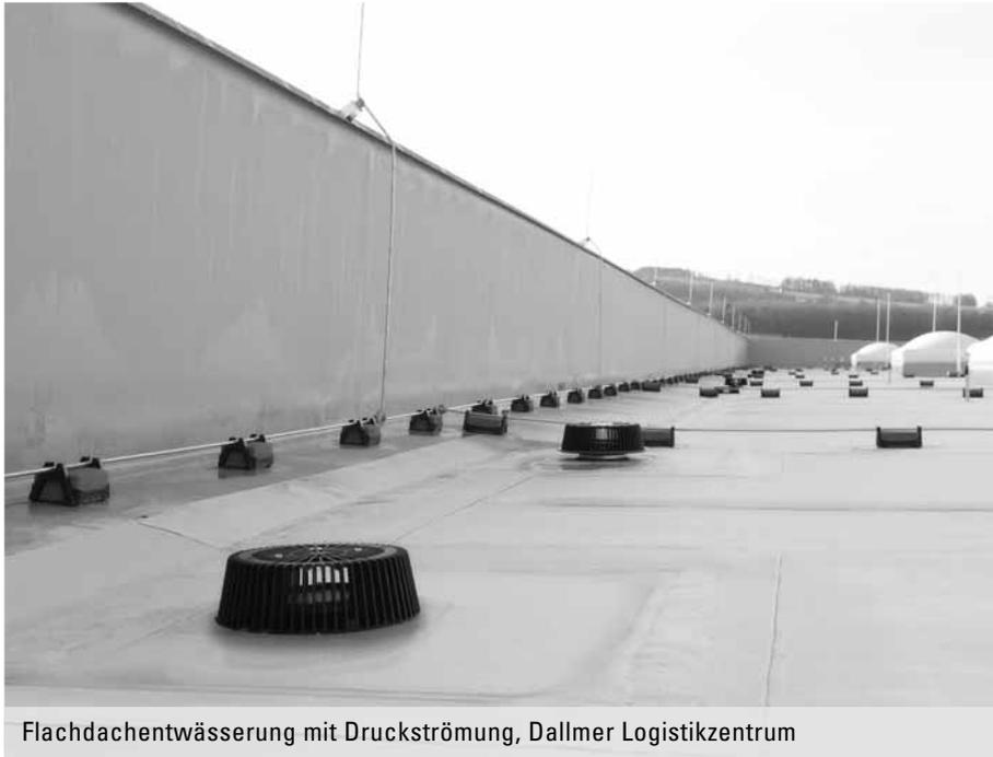
Flachdachentwässerung mit Druckströmung, Dallmer Logistikzentrum
